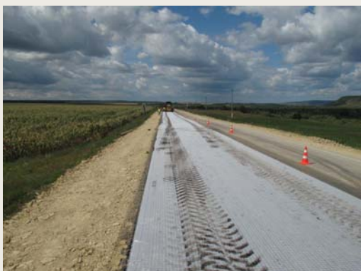
Адгезия TenCate Polyfelt® PGM G 100 к нижнему слою асфальтобетона
