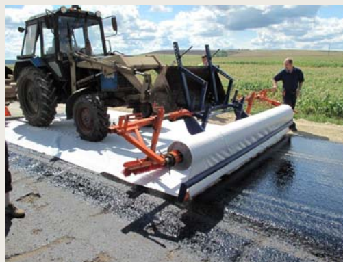
Использование навесного оборудования для укладки
