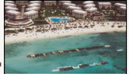
Контейнеры TenCate Geotube® расположены вдали от берега в качестве волнолома.
