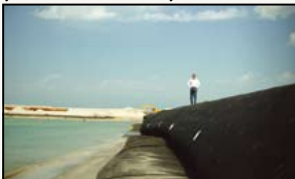
Контейнеры TenCate Geotube® укладываются один на другой, образуя защитное сооружение.
