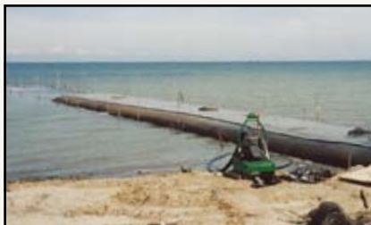
Укладка контейнера Geotube® для создания волнореза на ферме по разведению креветок.
