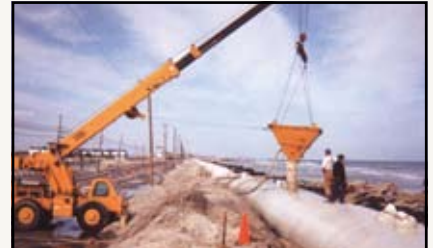
Контейнер TenCate Geotube® наполняется песком при помощи хоппера.
