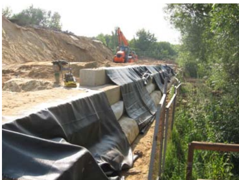
Бетонные блоки, используемые как временная опалубка
