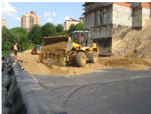
Устройство песчаного слоя над TenCate Geolon® PP
