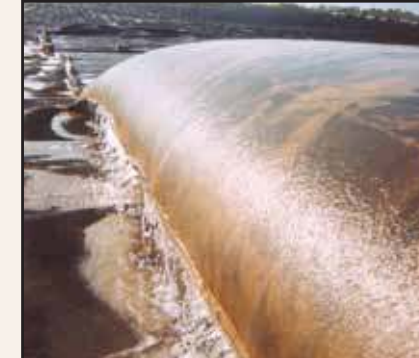
Pengeringan air dari Geotube®
