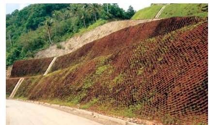
Envirocell® terpasang dengan tanah yang sudah diisi
