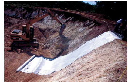
Tampak Polyfelt® TS digelar pada lereng yang dipotong
