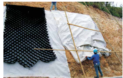
Pemasangan Envirocell® di atas Polyfelt® TS
