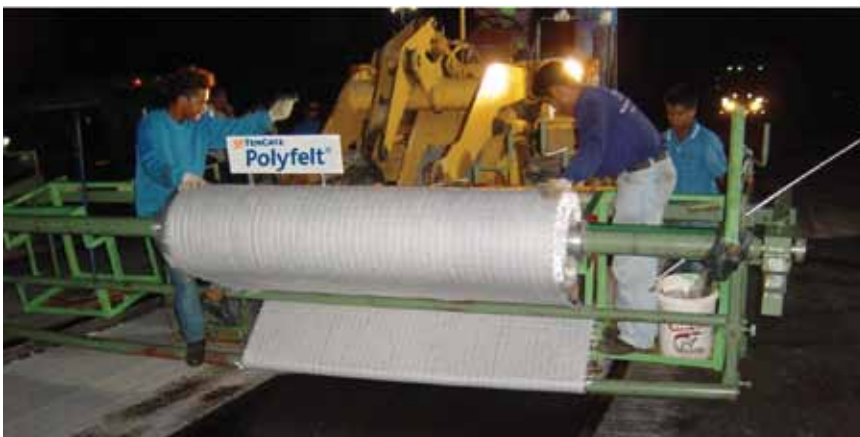
Penggelaran Polyfelt® PGM-G dilakukan oleh tenaga ahli / terlatih. Pekerja harus mengerjakan pada malam hari sehingga tidak mengganggu lalu lintas di salah satu kawasan turis terpenting di Thailand.
