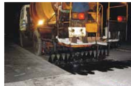
Aplikasi bitumen tack coat.
