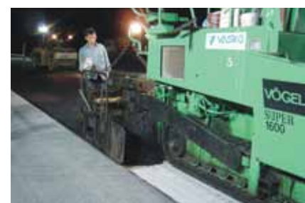
Pemasangan lapis permukaan (wearing course) final di atas paving fabric
