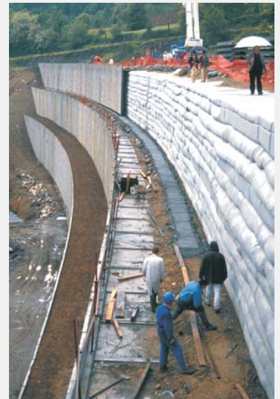
(a) Polyslope T mit Vorsatzschalung
