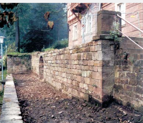
(c) Polyslope T mit Natursteinschichtung
