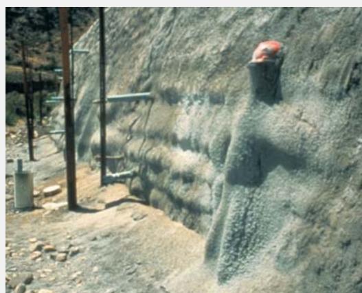
(d) Polyslope T mit Spritzbetonverkleidung
