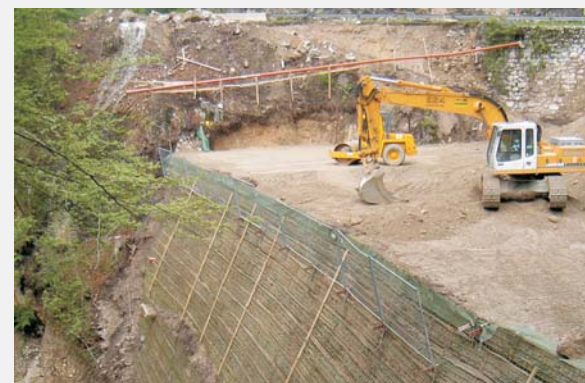
Einfacher, rascher und wirtschaftlicher Einbau sowie optimale Bedingungen für den Pflanzenwuchs zeichnen das System Polyslope S aus. (oben: Bauphase, unten: Zustand nach 1 Jahr!)
