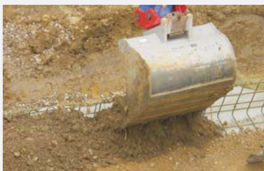
Anstehender Boden als Schüttmaterial
