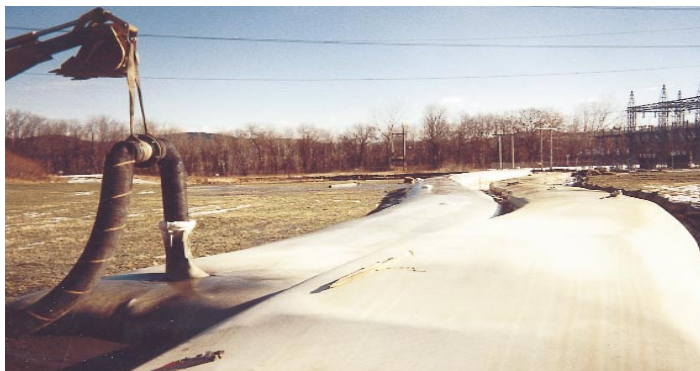
Figura 1: Geotubos en áreas de desechos. Cada tubo contenía enter 500 a 600 yd3 de desechos.
