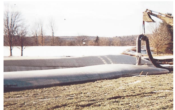
Figura 2: Geotubos siendo llenado con material dragado procedente del área de bocatoma de la planta.
