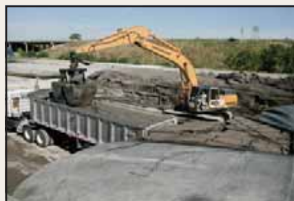
Lodo desidratado sendo removido com retroescavadeira.
