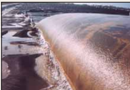
Unidade Geotube® em processo de desidratação.
