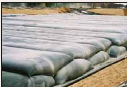
Unidades Geotube® desidratando lodo ativado em fábrica de papel.
