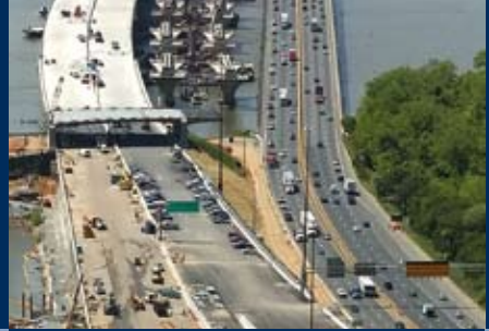
Toepassing van Geosynthetics bij een wegen- en bruggenbouwproject in Washington DC (zie blz 9)
